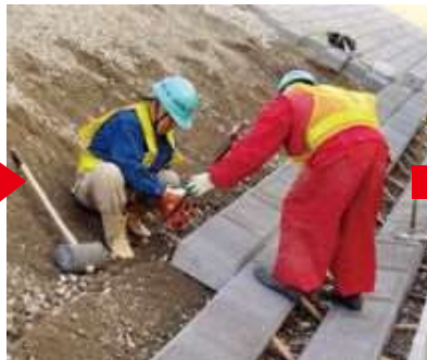
ブロックの据付
