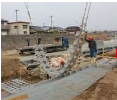
専用吊り金具にてマットを敷設します。
