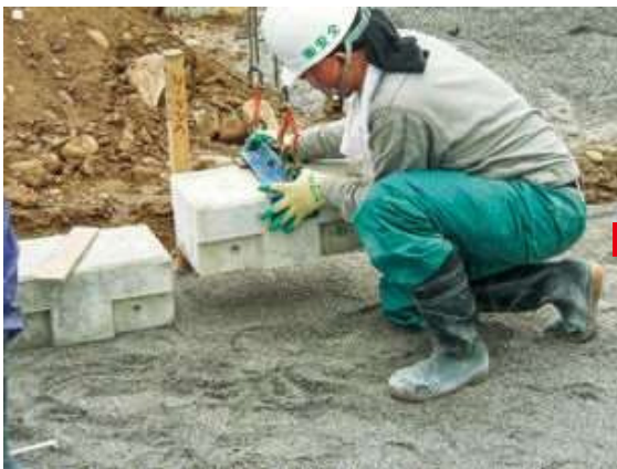
グラスサム用境界ブロック敷設状況
