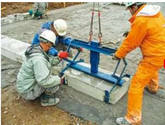
グラスサム用白線ブロック敷設状況
