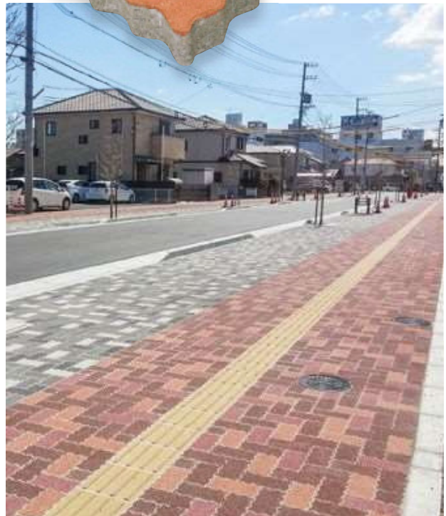
橋北ふれあい道路(三重県津市)
