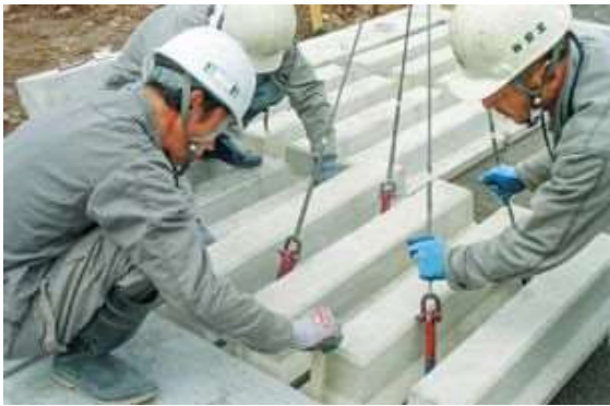
グラスサム敷設状況
